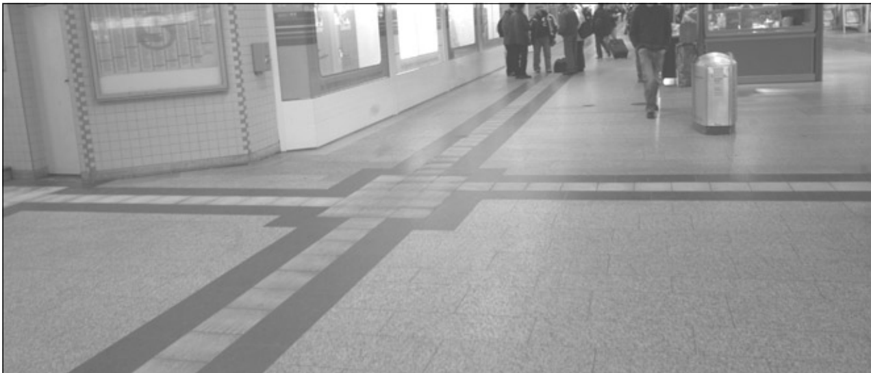
Blindenleitsystem im Innern des Hbf-Gebäudes
