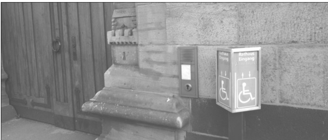
Schwere Türen am Nebeneingang
